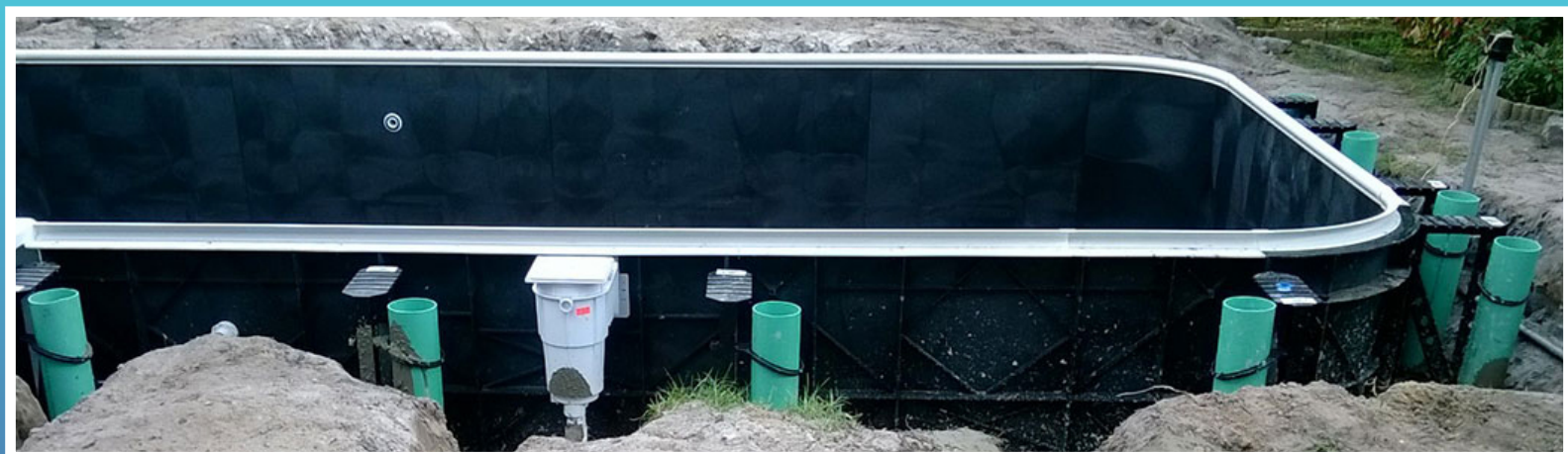
SONO TUBES PLACED AROUND POOL
